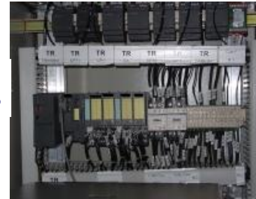
Armoire contenant un automate de sécurité et le programme SIL 3
